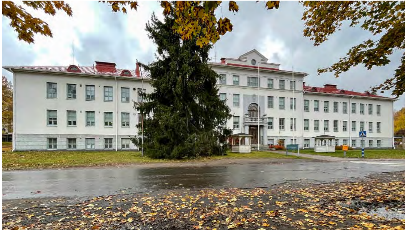
Kuva. Päärakennus muodostaa kiintopisteen ja keskeisen elementin alueella.
